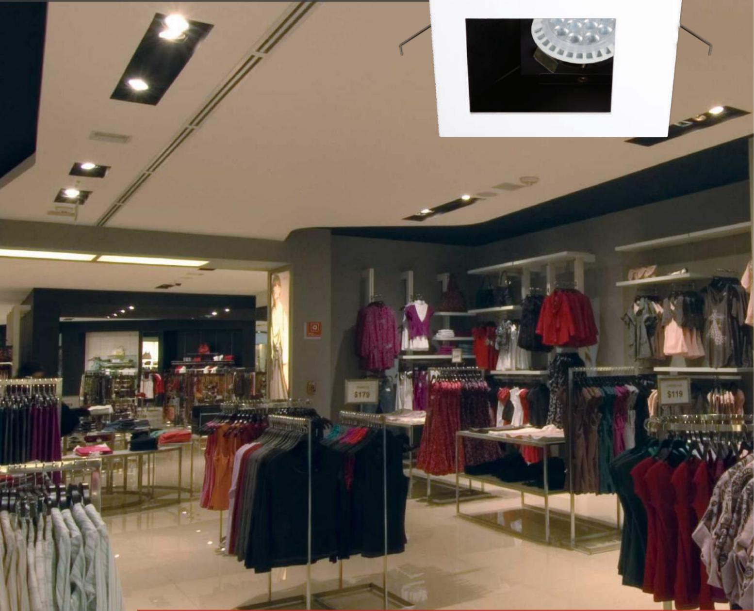
Esta familia de luminarias de empotrar, esconden la lámpara en su interior para evitar un posible deslumbramiento, son fáciles de empotrar en techo y permiten el mantenimiento por sustitución de lámparas tipo MR-16, con base GU10.
